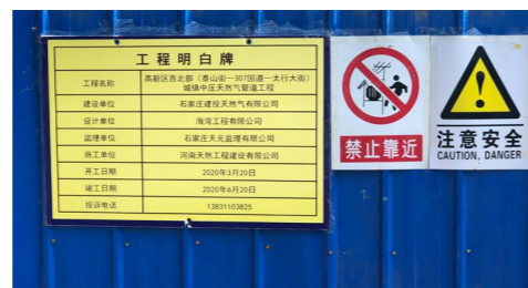
天然气公司施工现场设置围挡和工程明白牌
