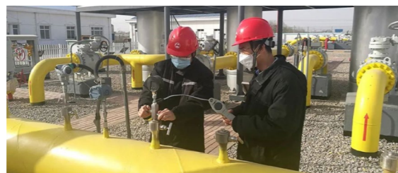
对压力管道连接仪表进行检漏
