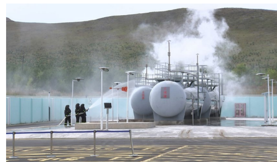
氢气泄露应急演练现场
