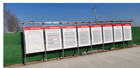
天然气公司施工现场设置五牌一图
